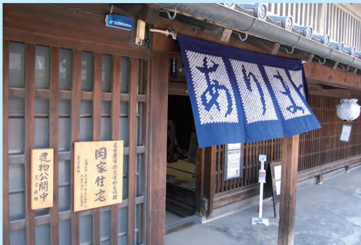
〈岡家住宅〉 名古屋市長指定文化財・都市景観重要建築物 江戸末期に建造され、一棟の建物としては有松で最大級。連子格子・なまこ壁・虫籠窓・塗こめ造りなど重厚な建築形態を今に残している。
